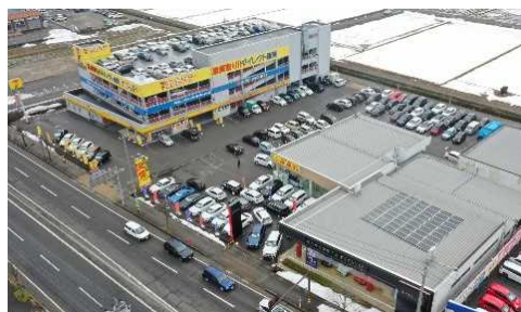
ESTAVIA福井に設置された太陽光発電設備
